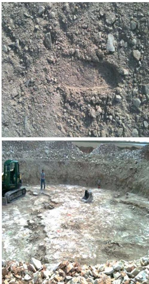
Il est important de mentionner que dans la plupart des cas, les sols sont sensibles à l'eau et aux variations hydriques, d'où la nécessité de protéger les fouilles par un béton de propreté après leur ouverture et de ne pas les laisser sans protection tant à la pluie qu'au soleil. Les sols sensibles aux variations hydriques (humidification ou dessiccation) doivent être protégés afin de préserver leurs caractéristiques mécaniques.
