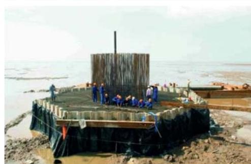
Il existe aussi le problème de poussée d'eau mentionné précédemment par M. Bourne. La poussée d'eau signifie un soulèvement de la fondation dont le volume doit être augmenté de 25 % à 50 % pour pouvoir résister à cette poussée d'eau.
