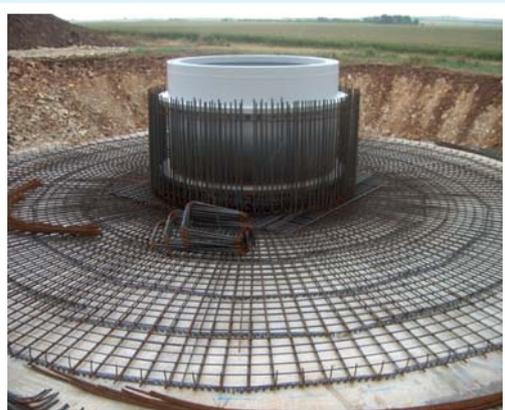
Les tours en béton armé sont de plus en plus fréquentes : Au lieu de virole ou de cage, ce sont des barres d'armature en attente qui peuvent atteindre 5 mètres de hauteur qui reçoivent la tour en béton armé.
