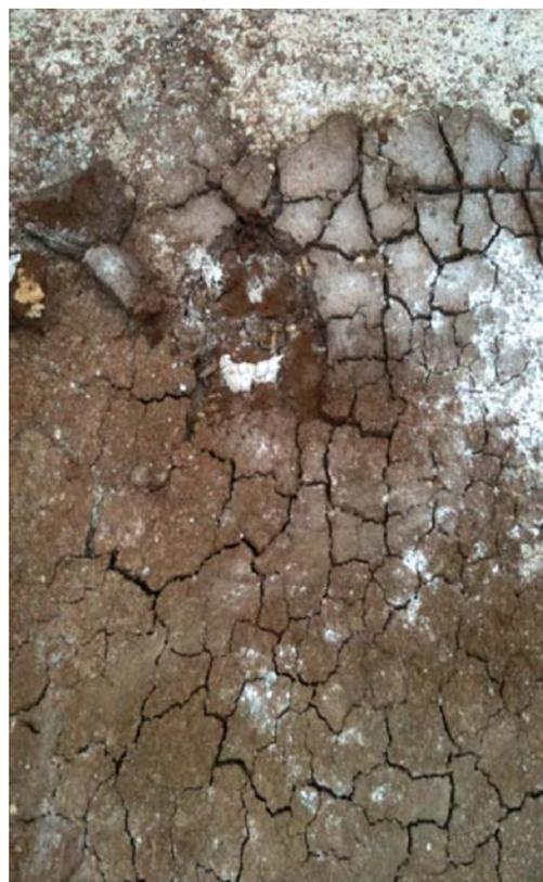
Le deuxième cas se situe dans le Pas-de-Calais : une fouille avait été pré-ouverte et laissée sans protection ; avec les pluies de printemps, elle s'était complètement remplie et a fini par se vider par le trou montré sur la photo. Ce trou avait été percé pour les sondages et avait été rebouché ; cependant avec la pression de l'eau et les différences de perméabilité, on a assisté à un débouffrage du forage dans la craie et l'eau s'est vidée par l'intermédiaire de ce trou.
